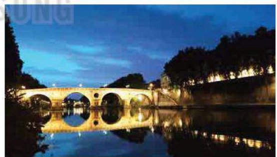
Cầu Ponte Sisto ở Thủ đô Rome của nước Ý
